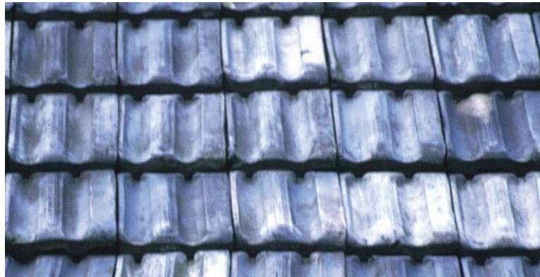
Beispiel für gedämpfte Dachziegel: Deckbild (historische Doppelmuldenfalzziegel)
