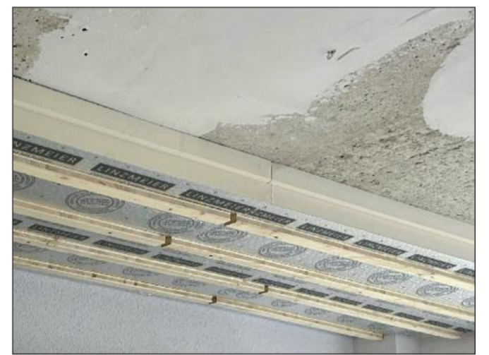
Neben der kurzen Montagezeit bietet die neue Innendämmung LINITHERM PAL UK eine minimale Aufbauhöhe dank hoher Dämmeffizienz (λ 0,023). Die raumseitige Beplankung ist frei wählbar, die elektrische Ausstattung (LED-Spots, Steckdosen etc.) lässt sich schnell und sicher einbauen oder nachrüsten.
