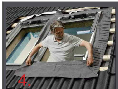
Auf der äußeren Seite werden die Anschlussschürzen wie bewährt plissiert sein; der zwischen den Dachfenstern liegende Bereich wird für eine leichtere Verarbeitung künftig glatt gefertigt.
