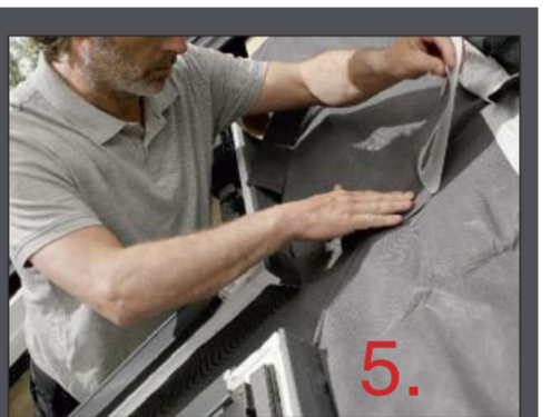
Mit dem im Lieferumfang enthaltenen Klebeband lassen sich die übereinandergelegten, glatten Schürzen ganz einfach und sicher abdichten.
