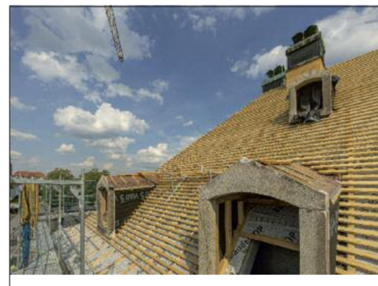
Das Dach des zum Teil denkmalgeschützten Gebäudes wurde im Zuge der Umgestaltung für das Archiv der Avantgarden authentisch wiederhergestellt. Für die Holzkonstruktion der Dachfläche wurden über 70 Kubikmeter Brettschichtholz und bis zu 11 Meter lange Sparren verarbeitet.
