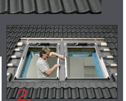
Die neue, patentierte Mittelrinne kann flexibel je nach Fensterabstand um maximal sechs Zentimeter bis an das rechte Fenster herangeschoben werden.
