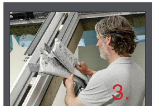
Auf den im Lieferumfang enthaltenen Anschlussschürzen ist jeweils vermerkt, ob sie auf der rechten und/oder linken Seite zum Einsatz kommen.
