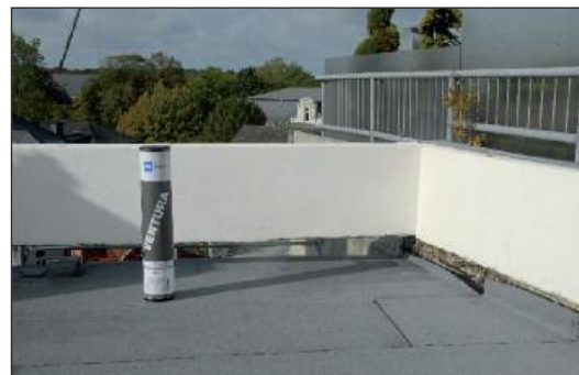
Schön dicht und schön lichtgrau: fertiger Teilbereich der Flachdachterrasse mit der Oberlagsbahn Icopal Ventura.
