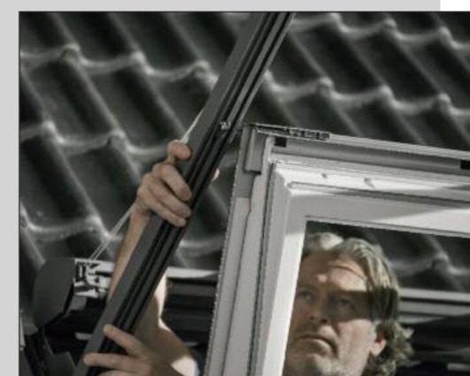
Für Effizienzsteigerungen beim Einbau des neuen Rollladens sorgen beispielsweise Klick-on-Lösungen: Sie reduzieren Einbauschritte und gewährleisten eine schnelle sowie sichere Montage von innen.
