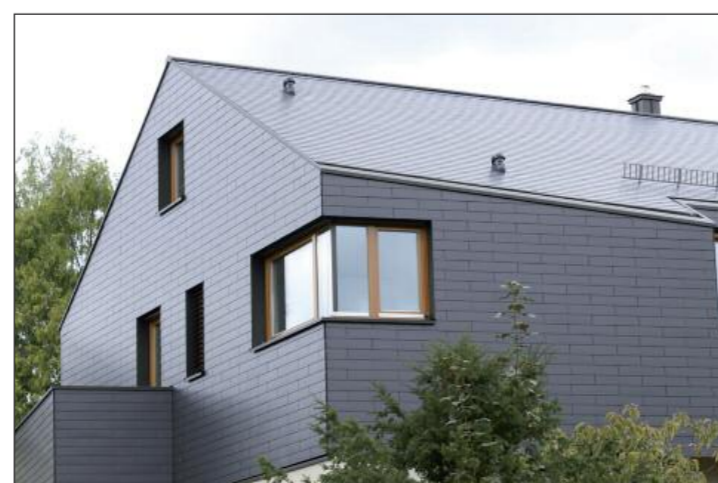
Einfamilienhaus in Ostelsheim mit Linumdeckung im Format 32 x 60 cm. Die moderne Deckungsart betont die horizontalen Linien und unterstreicht die klare architektonische Struktur des Gebäudes. Bild: Conne van d'Grachten
