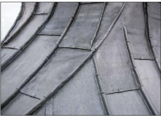
Zur indirekten Befestigung der unterseitig verzinnnten Bleischare kommen haltbare Edelstahlfalte- und -schrauben zum Einsatz.
