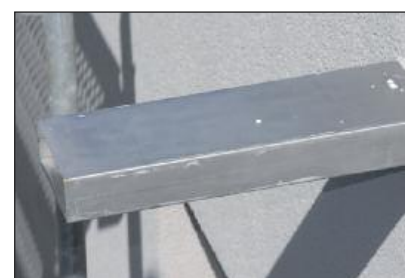
Power-Entwässerung über den Power-Attika-Ablauf.
