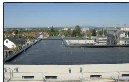
Fertig abgedichtet – und bereit für die Begrünung.
