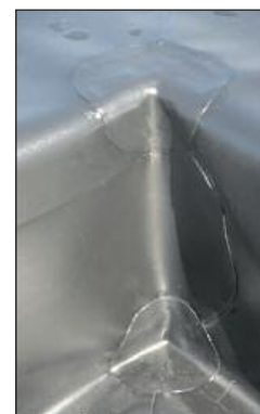
Vorgefertigte Innen- und Außenecken erleichtern die händische Verschweißung im Detail.
