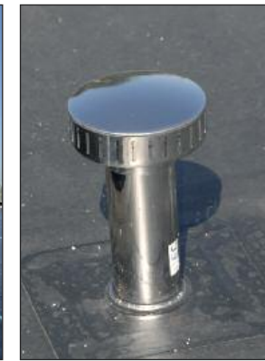
Freie Bahn für die Abluft: Edelstahl-Lüfterelement.
