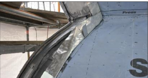
Zur indirekten Befestigung der unterseitig verzinnnten Bleischare kommen haltbare Edelstahlfalte- und -schrauben zum Einsatz.
